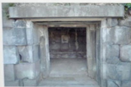
石室の内部 Interior of the stone cellar
